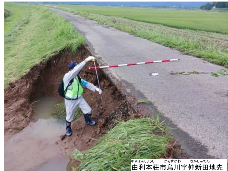
防災エキスパートによる出水状況把握状況②
